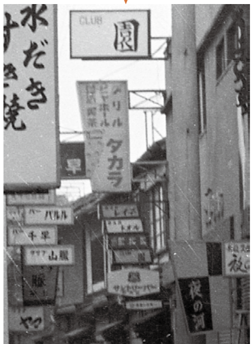
1960年代の先斗町。 右奥に「鴨川会館」、 左奥に「先斗町会館」がある(上写真)。 茶色部分の拡大図(下写真)を見ると、 右は「CLUB園」「グリル/ピヤホールタカラ」 「BARレイ子」「BARえりか」「BAR酔族館」、 左は「バーバル」「バー千早」 「クラブ山脈」「クラブヤマ」という 看板がある。
