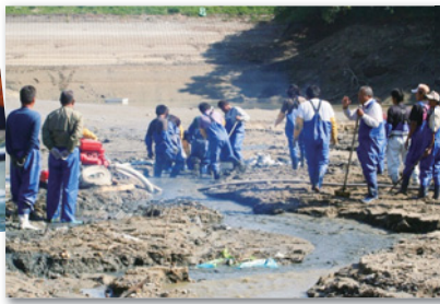
写真3 農業者と漁業者によるため池の「かいぼり」(池ざらえ)
