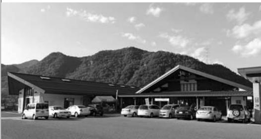
木造平屋建ての中央棟(右)と西棟は、長良杉使用の木造大断面構造。建築基準法で規定する損傷防止、倒壊防止基準に対しては1.5倍の耐震性能を持ち、震度6強にも耐えられるという
