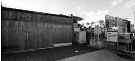
中央棟・西棟の裏にある防災備蓄倉庫(左)。構造用合板による耐力壁で構成している。中央に見えるのは自家発電装置、右奥は備蓄用飲料水の受水槽
