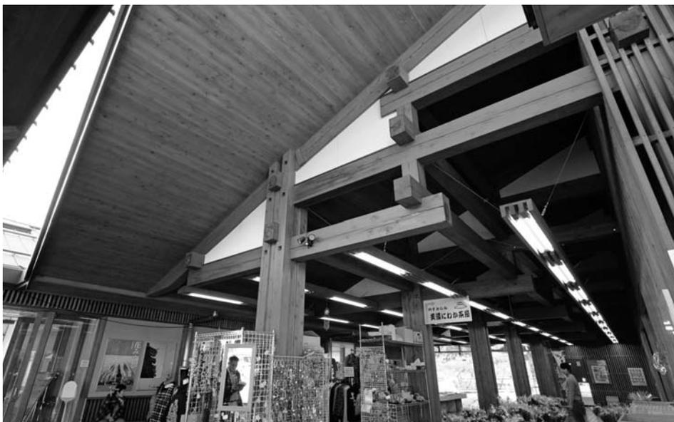
周囲に4m張り出した切妻屋根の片側部分。深い軒先の張り出しで建物を風雨から守る役割も果たす。太い柱や梁などは45分の火災にも耐える性能になっている
