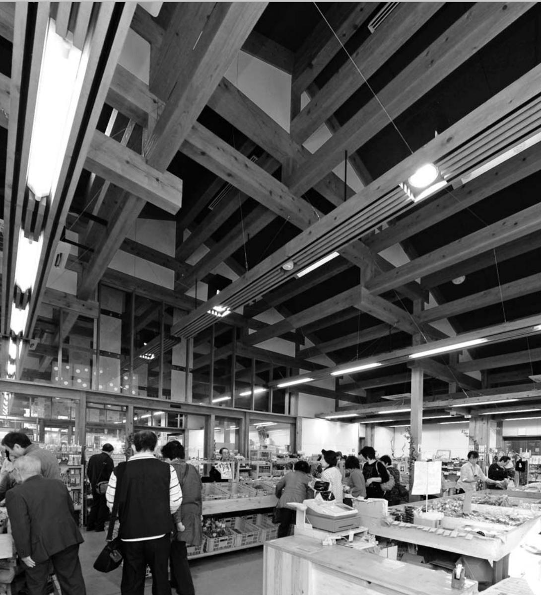
中央棟の特産品販売フロア。日本建築伝統の組物(くみもの)を応用して強度を得る「持ち送り構法」の建物で、天井の梁を7.5mもの長いスパンで架け渡している
