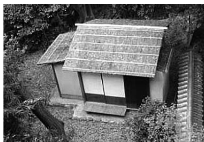
「甲乙塾」の塾生たちによって建てられた京都市東山区の茶室「甲乙庵」。ていねいに剥いた杉皮で屋根を葺いている
