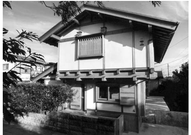
伝統構法の木組だからこそ可能な「せがい造りの家」。5段に組み上げた木組
