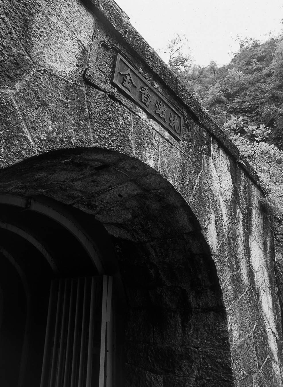
コワニエが築いた石造アーチは一分のくもらもなく、構造の確かさを物語っている
