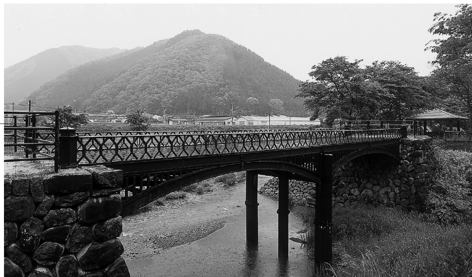
2連アーチで意匠にも凝った羽淵铸铁橋は移築保存されており、残念ながら渡れない
