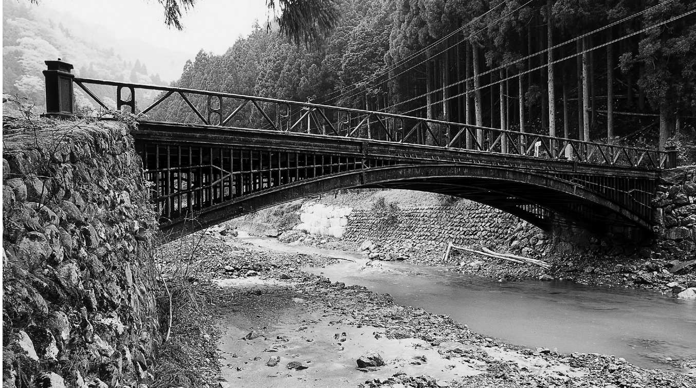
3本の铸铁アーチが路面を支える神子畑铸铁橋は、今も現役として使われている
