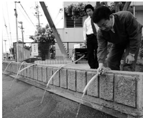
防災井戸には、非常用発電機で動く電動ポンプが設けられ、災害時には耐圧ホースの先の8つの蛇口から同時に利用できる
