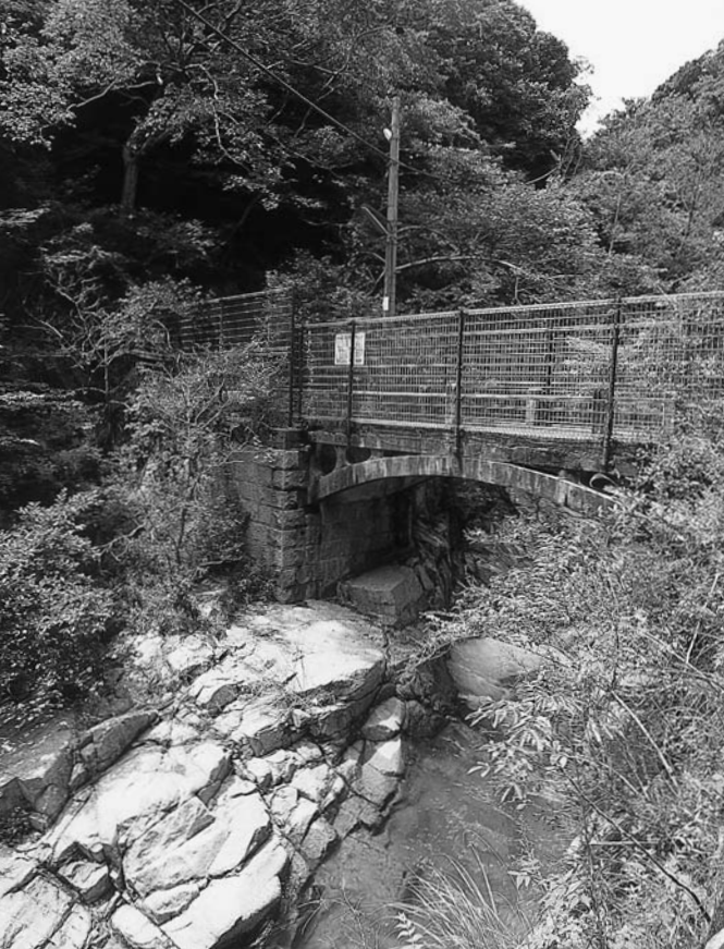
ダムへの山道、生田川に架かる谷川橋は 大正時代のコンクリート・アーチ橋
