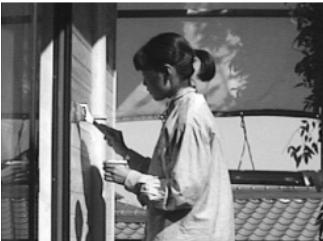
写真-2 檜の下見板に柿渋を塗る
