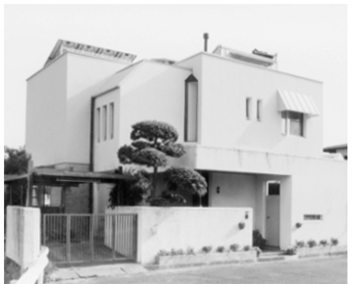
写真-5 学園前「再生エコハウス」北側外観
