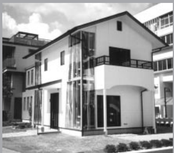
神戸市すまい・まちづくりフェアにあわせて建てられた「なるほど住宅」では、住宅の不具合部分を見て学ぶことができる
