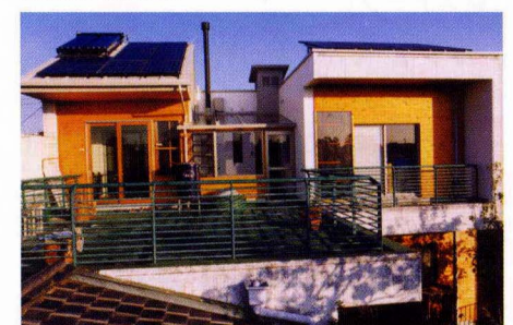
南側より(改修後)
