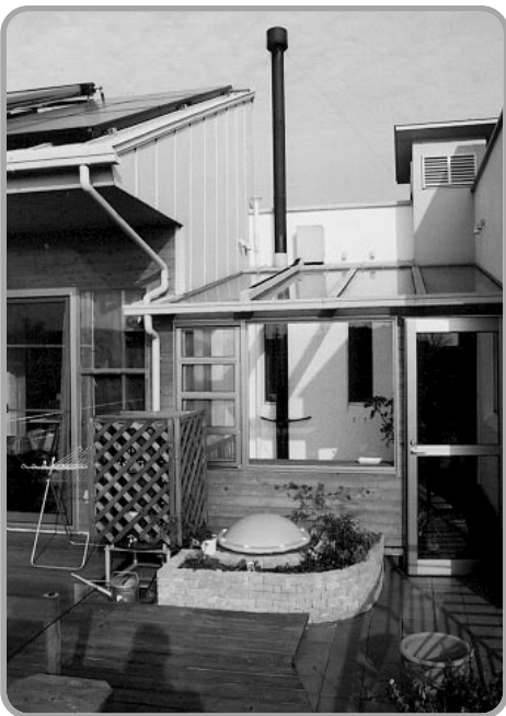
【写真4】 屋上テラスと建物
