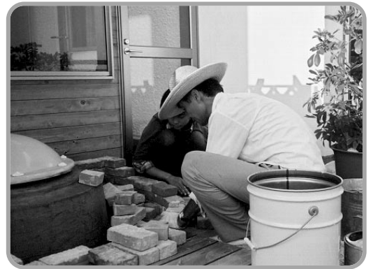
【写真1】煉瓦を積んでコンテナ作り
