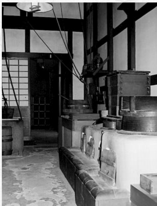
住戸内に組み込まれたオープンスペースともいえる土間空間「通り庭」(写真は住まいのミュージアム内大店の台所庭部分)
