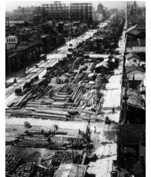
地下鉄工事中の御堂筋(昭和五年着工)
