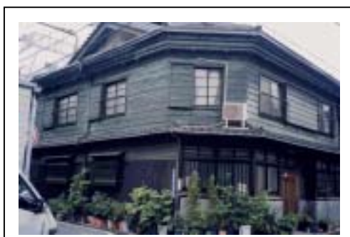
箱軒に銅版を張り巡らした長屋(福島区)
