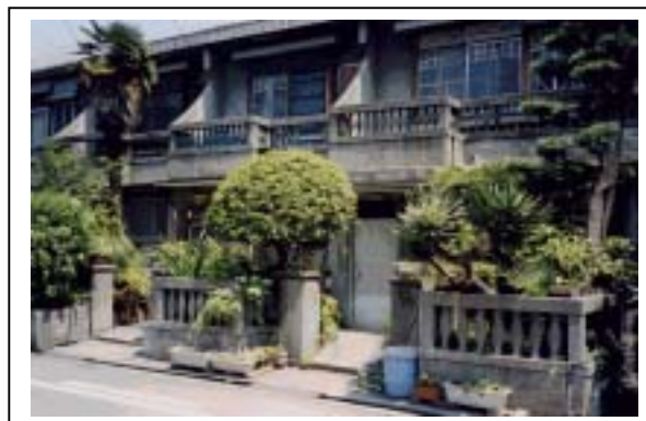
洋風の意匠が取り入れられた長屋(住之江区)
