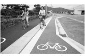
共用自転車の利用促進を進めるために、既存歩道を拡幅した自転車歩行 者道。自転車道は2m、歩行者道は1.5mで整備し、全体で3.5mの自転車 歩行者道となっている。また自転車道と歩道は、カラー舗装とインターロッ キングブロック舗装されている
