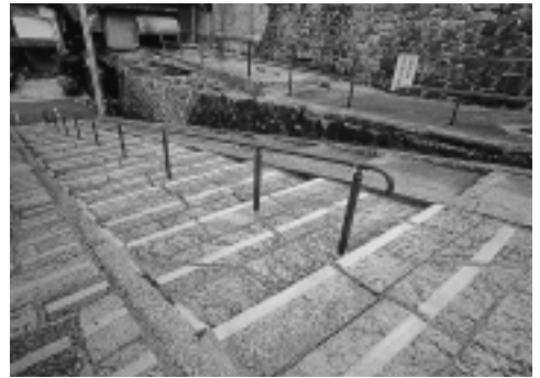
上町台地にあるため、西に向かって下っている空堀を代表する「観音坂」。異なる幅の石段が2列あり、その横には自転車などの利用のための坂も設けられている
