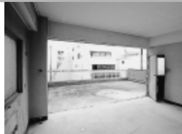
改修工事に入る前の「鎗屋アパートメント」。内装をすべて取りはらってコンクリートがむき出しになっている。この躯体(スケルトン)を活用して、居住空間としての設備・内装(インフィル)を創造的につくり出していくことになる
