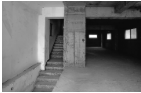
改修工事に入る前の「鎗屋アパートメント」。内装をすべて取りはらってコンクリートがむき出しになっている。この躯体(スケルトン)を活用して、居住空間としての設備・内装(インフィル)を創造的につくり出していくことになる
