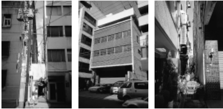
船場のコンバージョンの難しさ。太閤下水に沿う敷地に建つビル(中央写真)は水路敷(右写真)が担保されているも敷地奥は採光基準をうまく満たせないで、全棟の住宅コンバージョンは難しい。左写真も太閤下水による空間の一例
