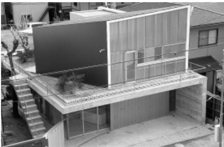
あらかじめスケルトンとインフィルを分け、リノベーションにも対応できるように考えて宮本氏が設計した住宅。100年は使えるインフラとしての人工地盤が印象的
