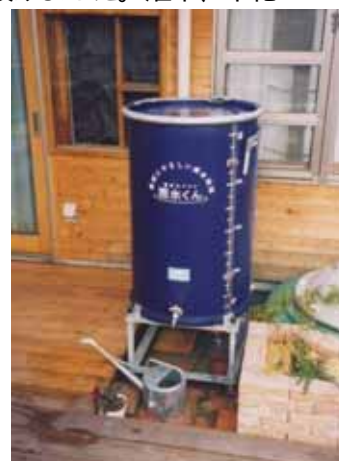
図-6 雨水貯留タンク 200リットル
