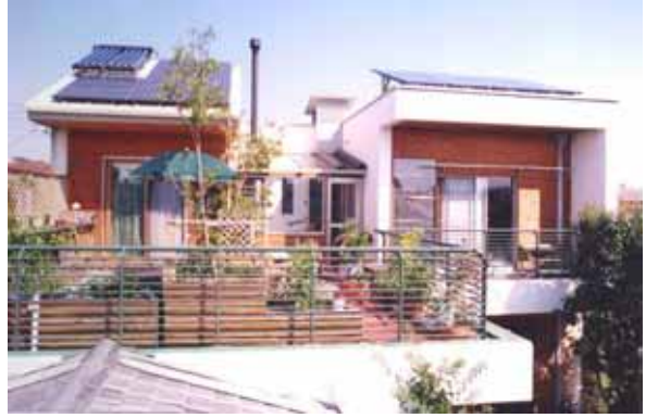
図 - 2 エコ改修と屋上テラス整備後の様子
