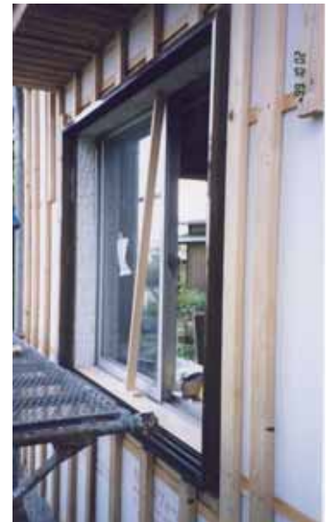
図 - 3 外断熱及びサッシ二重化工事
