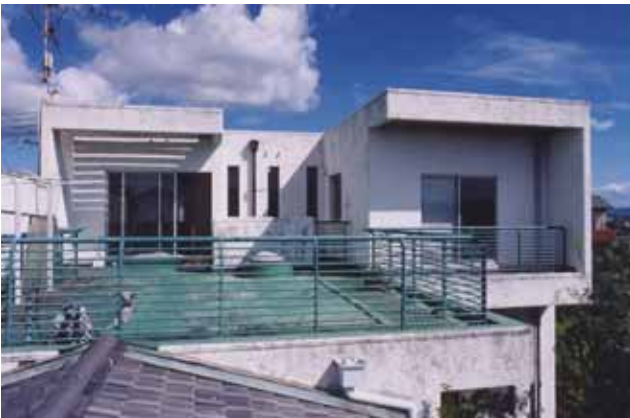
図 - 1 エコ改修前の状態
