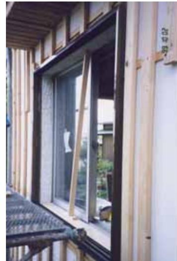
図3 外断熱及びサッシ二重化工事
