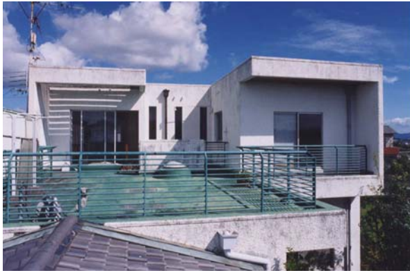
図 1 購入した中古住宅(改修前)
