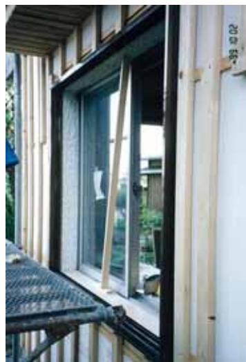
図 - 3 壁の外断熱及びサッシ二重化工事
