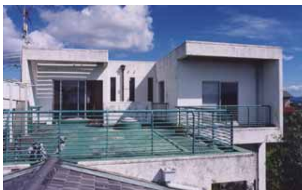
図 - 1 改修前の状態
