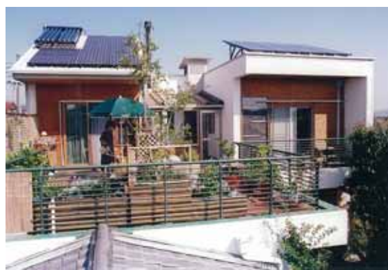
図 - 2 エコ改修と屋上テラス整備後の様子
