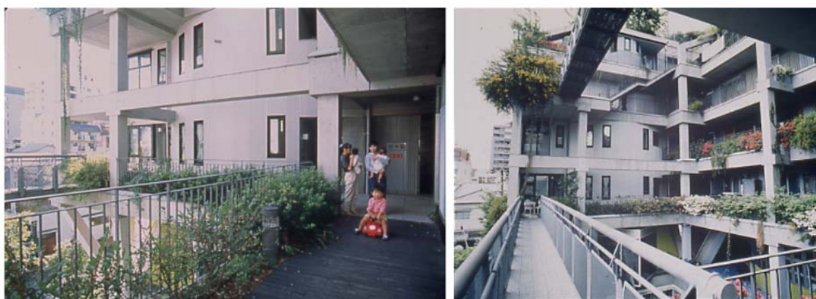
立体街路の様子
