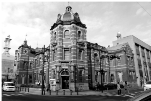
東京駅を設計した辰野金吾が手がけた赤レンガも美しい「岩手銀行中ノ橋支店」は、国の重要文化財に指定されている
