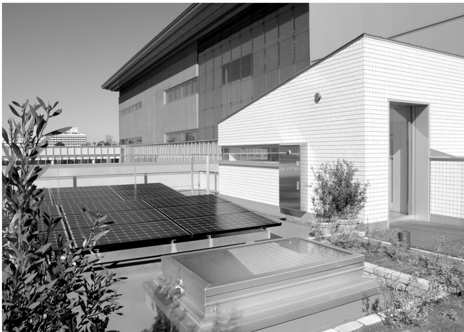
屋上は緑で覆うことで断熱性を高め、ソーラーパネルを採用することで自然エネルギーから電気を生み出している
