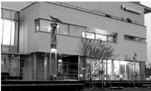
鉄骨構造(NSラーメン構造)で耐震性も確保されたイーユーハウス外観。周囲にはLED照明が設置されているなど、より省エネルギーで外観を美しく見せる工夫がなされている
