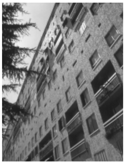
フレンヌの近代住宅プルブルール
