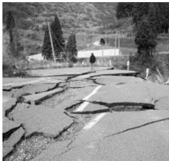
新潟県中越地震の被災状況
