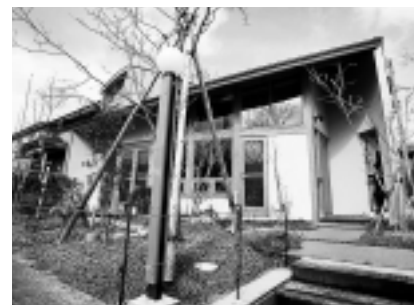
光と風を取り入れるために、大きな開口部を設けた小西邸の外観
