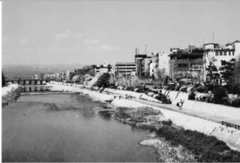
景観を考えて堤防は石積護岸になっている。また「花の回廊」づくりにより、緑豊かな川岸が実現している
