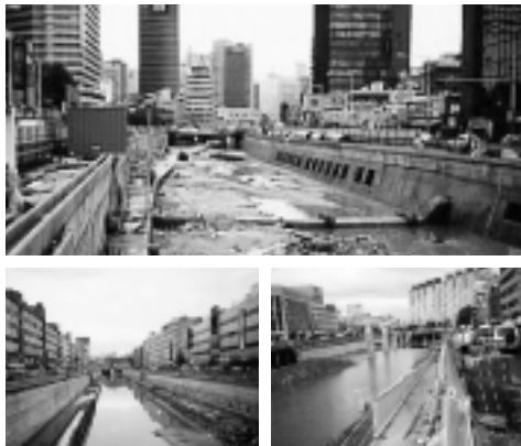
再生工事の進む清溪川の風景
