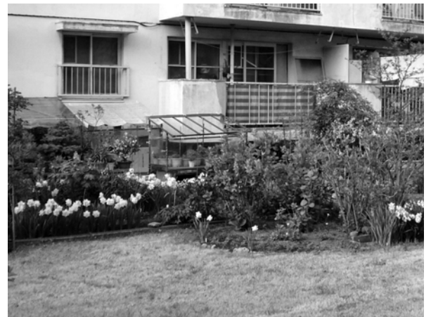
【写真1】花壇利用されている住棟南側オープンスペース
