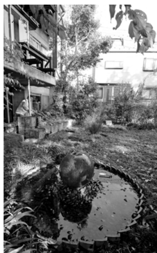
西の玉石に溢れ出た雨水は庭を蛇行してせせらぎ、東のろ過道を通して、再び地下水槽に貯まる
