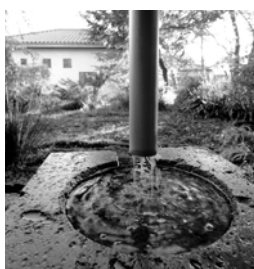
樋の中には落ち葉がたまり、雨水は少しずつ流れ落ちるようになっている。その結果、雨が上がった後でも樋の端から水滴が落ち続けるので、水音はしばらく絶えない
