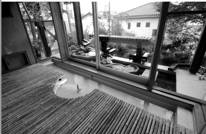
建物内部にも雨水が引き込まれ、屋内の池が造られている。冬の雨水は太陽熱をいっぱい吸って、部屋を温め、潤してくれる。デッキ上に設けられている外の池との一体感が生まれるように水が配置されている
