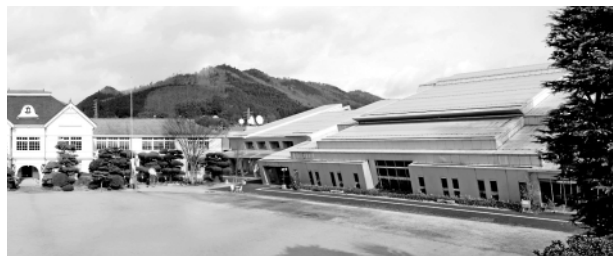
久世エスバスセンターは、旧遷喬小学校を久世町のシンボルと考えていることから、できるだけ校舎を大きく見せるように、校庭側の屋根が低くなるように設計されている
