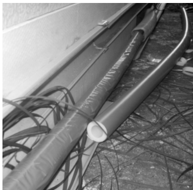
【写真12】 温水配管の保温強化(右、施工前)
