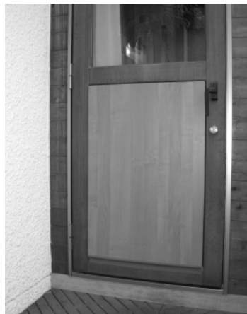
【写真09】 勝手口ドアの断熱改善
