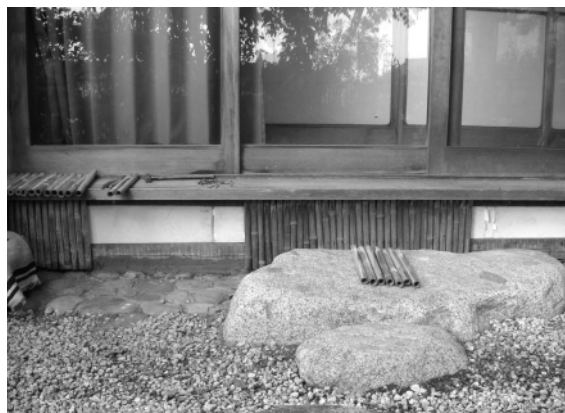
【写真04】 縁側床下の閉鎖
