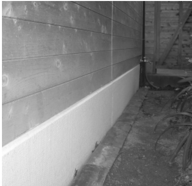
【写真07】 基礎の外断熱
