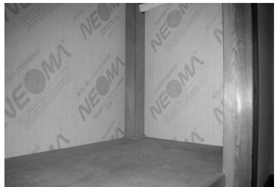
【写真08】 押入れの断熱追加
