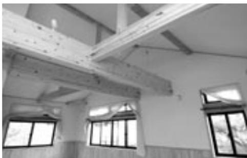
壁や床には中に空気が移動できるドイツ発祥の「リグノ工法」とい、木質の複合パネルを使った工法を採用している。『呼吸する』壁や床が実現し、熱を自然にコントロールする。さらに耐久・耐震・耐火・遮音性が優れているだけでなく、ダニやカビの原因となる結露を防ぐなど、人体への悪影響を減らす効果もある
