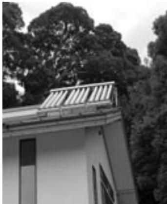
屋根の最上部に設けられた突起は、室内の熱を排出するのが目的。また、効率のいい太陽熱温水機も屋根に設置されている
