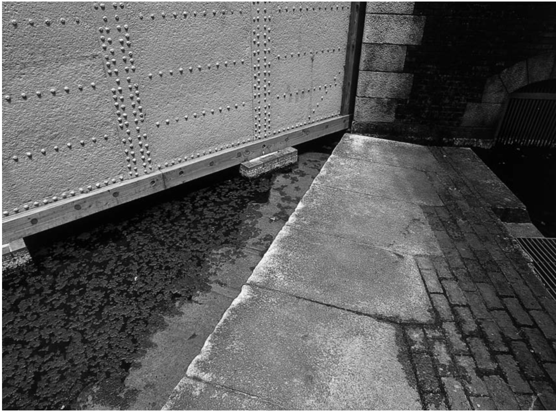
旧閘門の制水扉の基底部、全体はレンガと重厚な鉄扉による構造
