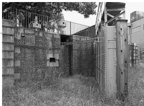
鉄扉の先端には太い木の角材が取り付けられている
