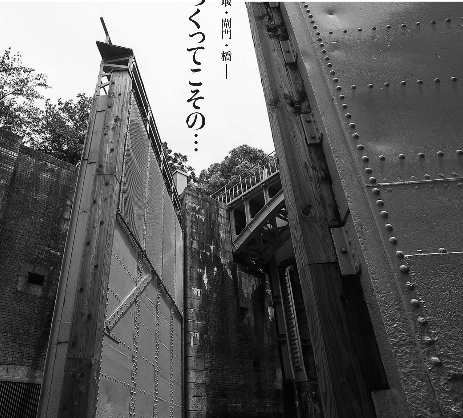
旧毛馬第一閘門上流側の制水扉
