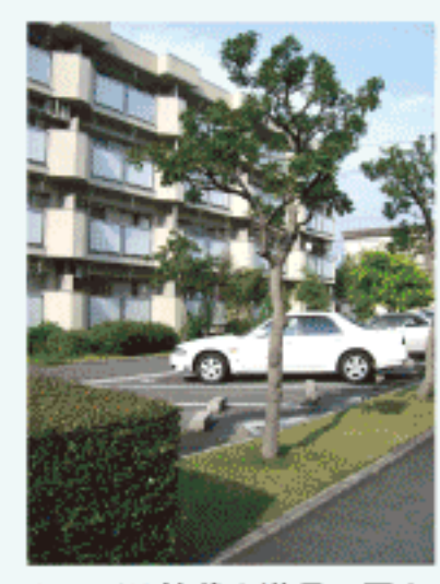
かつては植栽や遊具に囲まれていた市営小宮住宅
