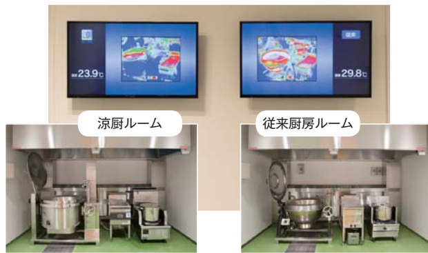
「ハグミュージアム」5階の「涼厨体感ルーム」 涼厨ルーム(左)では、従来厨房ルーム(右)より4～5℃室温が低いことを実際に体感可能。さらに、サーモビューと温度表示でその効果を確認できる。
