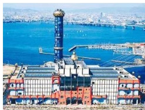
図9. 舞洲スラッジセンター
