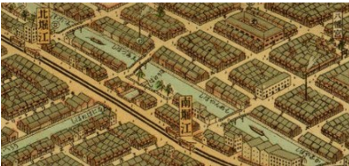
図 11. 斜めに架けられていた清水橋※ 1
