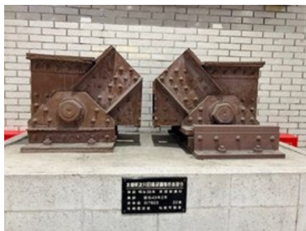
図 5. 新淀川旧橋梁沓部分 ：阪神電鉄淀川駅構内 （撮影：筆者）
