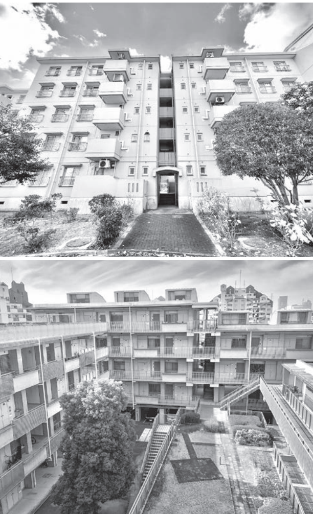
上／1982年竣工、日本におけるスケルトン・インフィル方式集合住宅の第1号「泉北桃山台B団地」（堺市）。 下／賃貸団地でスケルトン・インフィル方式が採用された物件は珍しく、1999年竣工当時の「ふれっくすコート吉田」（東大阪市）は大きな注目を集めた。提供／筆者（以下すべて）
