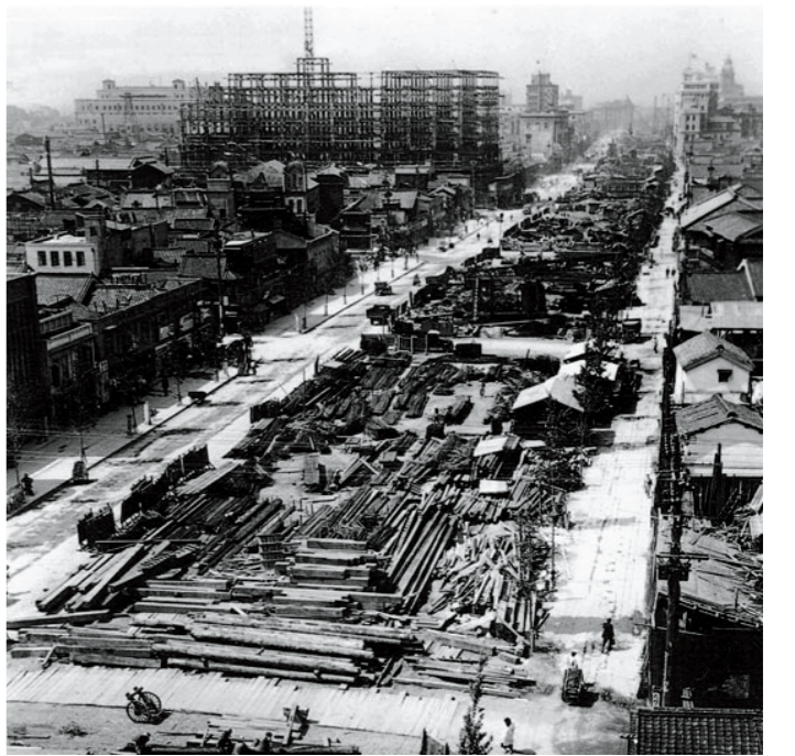
『近代から未来へ 大阪御堂筋ものがたり』本章より、地下鉄（御堂筋線）の工事の様子。左奥は建設中の大阪ガスビル。写真提供/大阪市
