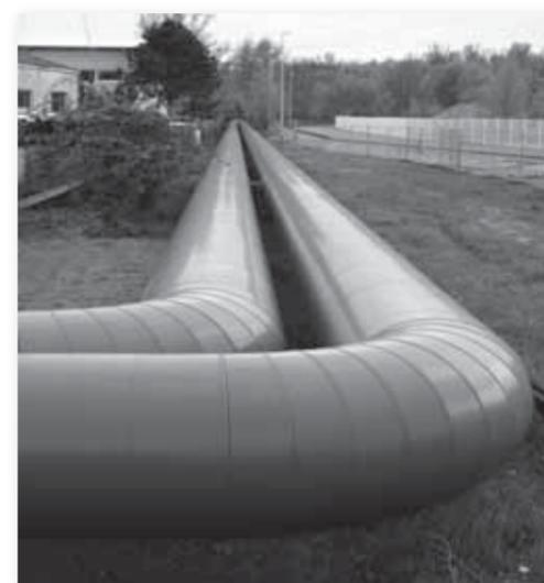
地域熱供給の送水管。送りと戻しの2本で温水を循環させる
