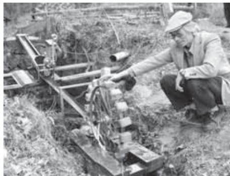
すげの里の脇を流れる沢水に設置された小さな水車でマイクロ水力発電を行う。「獣害よけ電気柵や照明の電源に活用しています」と高野准教授
