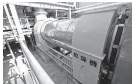
汚泥乾燥機。消化ガスと消化ガス発電機の熱を利用して脱水汚泥を乾かす(上図)
