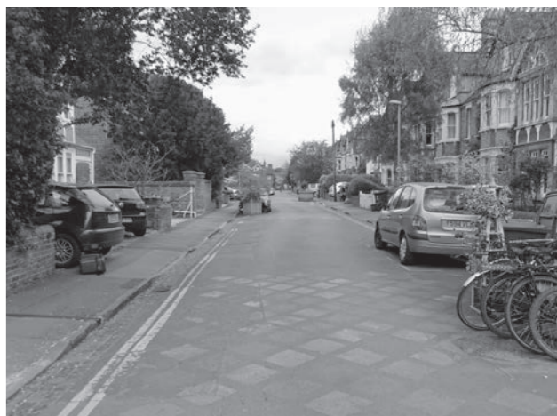
プランターを用いた狭窄と、カーペットと呼ぶ路面装飾。
