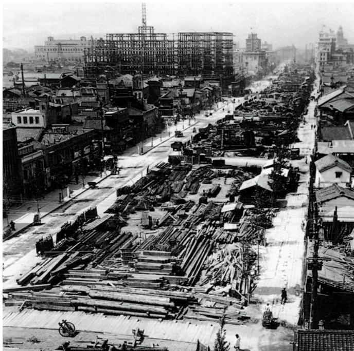
『近代から未来へ 大阪御堂筋ものがたり』本章より、地下鉄（御堂筋線）の工事の様子。左奥は建設中の大阪ガスビル。写真提供／大阪市
