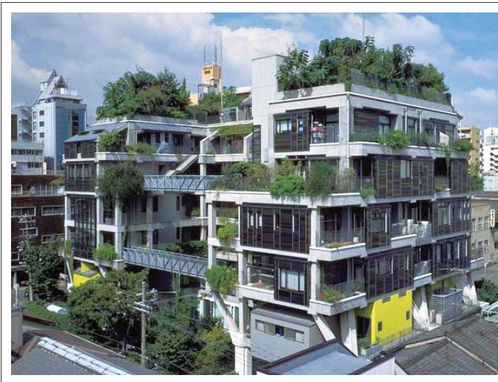
大阪ガス実験集合住宅 NEXT21
