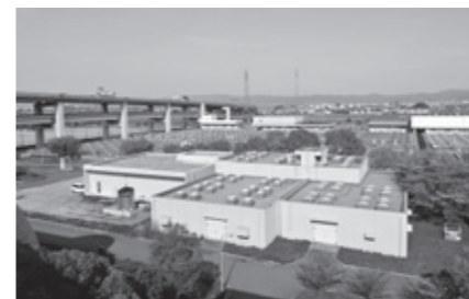
洛南浄化センター全景。手前の建物が汚泥濃縮棟で、奥に見える最終沈澱池から引き抜いた汚泥を濃縮し、後の処理をしやすくする
