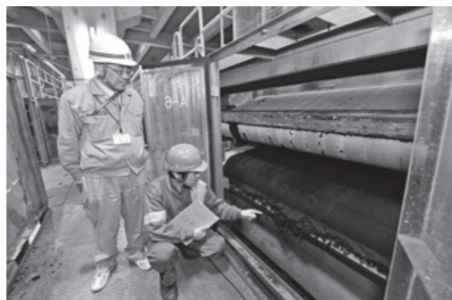
ベルトプレス型汚泥脱水機。汚泥に含まれる水分を取り除き、固形の脱水汚泥にする(上図②)
