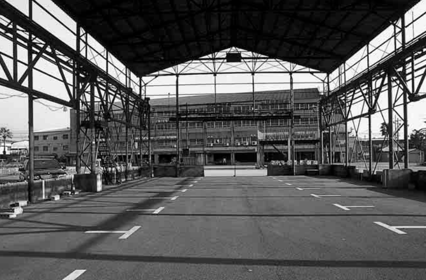
鉄骨組だけを残すドック脇の工場棟。まるで、これから新たに建設がなされるかのような雰囲気を持っている
